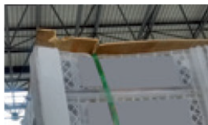
Parillas rajadas por falta de esquineros.
